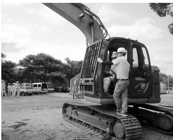
グラップル操作は、オペレーター技術の高いメンバーが指導した
