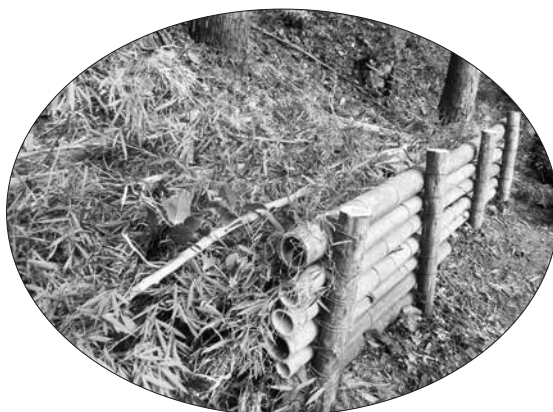
土砂崩れを防ぐ竹柵工
