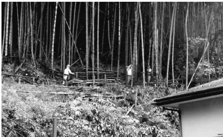
民家そばでの侵入竹の伐採。伐り倒した竹は引き出してから細かく刻む
