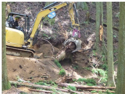
写真① ザウルスによる作業道の作設
