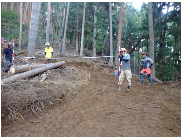
写真 4 ヘアピンカーブ仕上がり状況の確認
