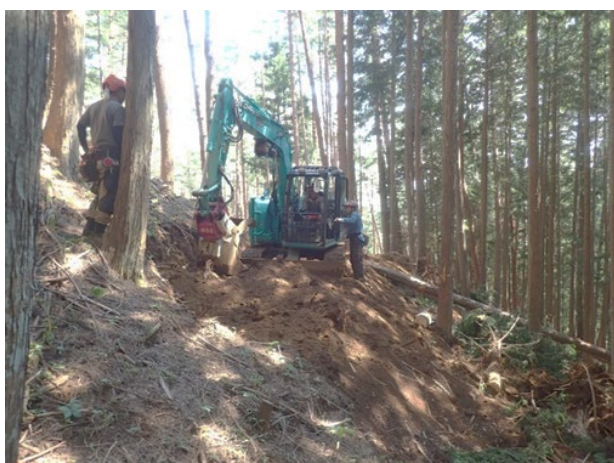
写真3 現地指導 作業道作設実施状況
