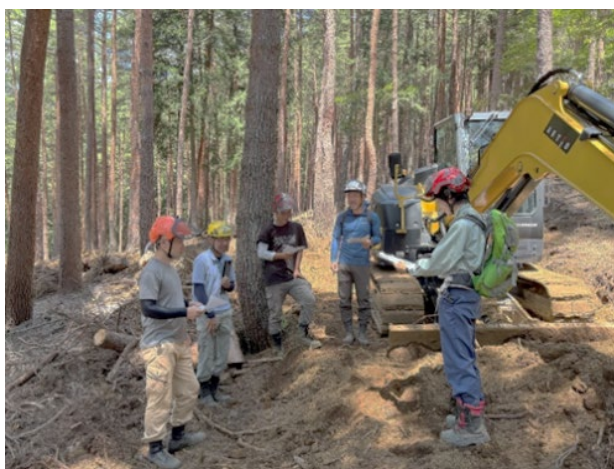
写真2 現地指導 計画・作設方法の説明状況
