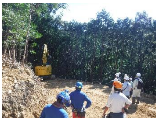
森林作業道作設状況
