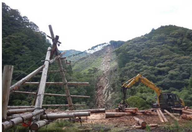
写真：民間事業者による架線を使用した皆伐現場
