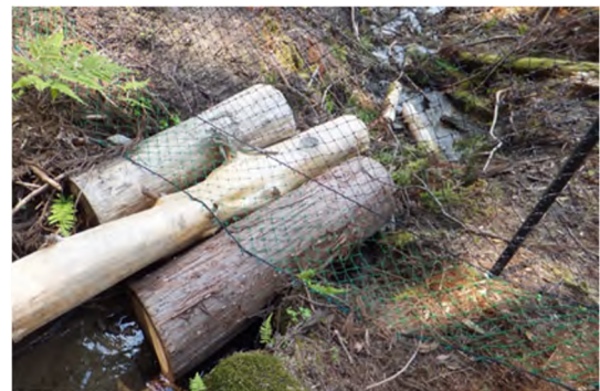
写真2 沢跨ぎ方法の改善（丸太を使った排水）
