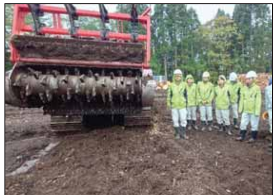
【写真】外部講師より、自走式伐根粉碎機の説明を聞いている様子
