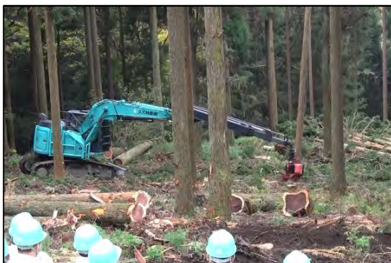
【写真】ロングリーチグラップルソーでの伐倒
