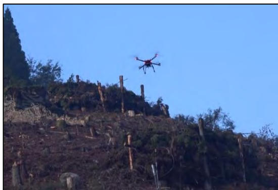
【写真】ドローンで資機材（ポール）を運んでいる様子
