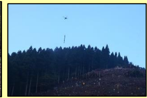
ドローンによる資機材の運搬
