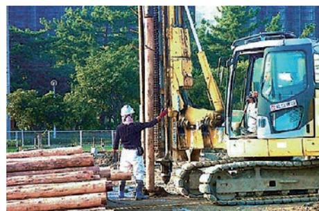
写真7-9 丸太打設による軟弱地盤改良
