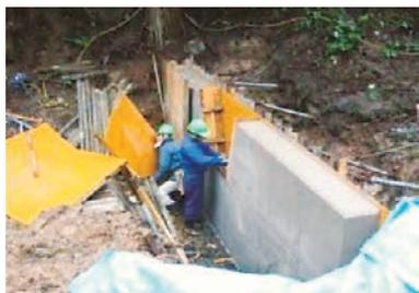
写真7-5 コンクリート型枠用合板
