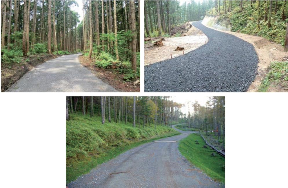
写真5-2 林業専用道(のり面は低く抑えられ、土工量が小さく、林内へのアクセスが容易)
