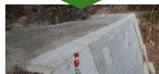
擁壁工等による路肩の強化
