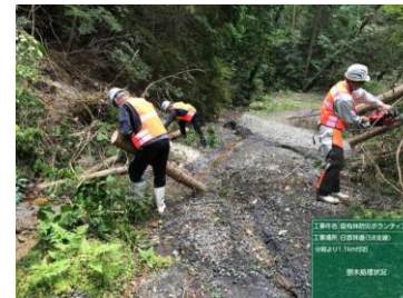
応急対策の実施(倒木処理)
