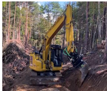
林道工事などの狭小な現場でも 掘削・法面整形が可能
