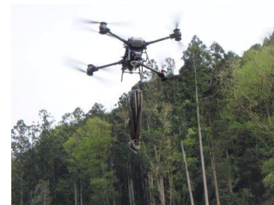
大型ドローンによる資材運搬
