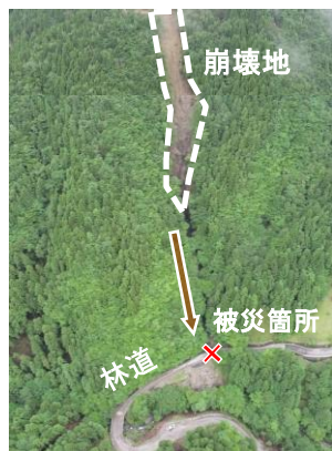
ドローンによる 災害箇所の調査
