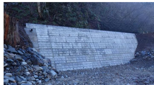
大型ブロック積工
