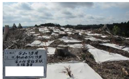
（防草シート設置状況）
