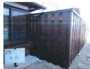
（花久の里外構工事）
