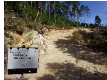
（森林作業道補修支援） 作業完了後
