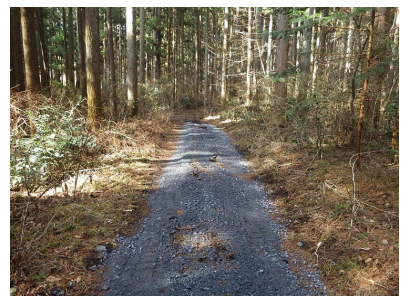
(砕石支給実施後)
