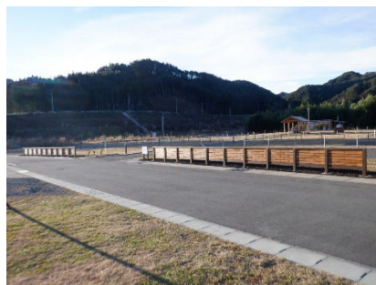
（釜石市設置状況）
