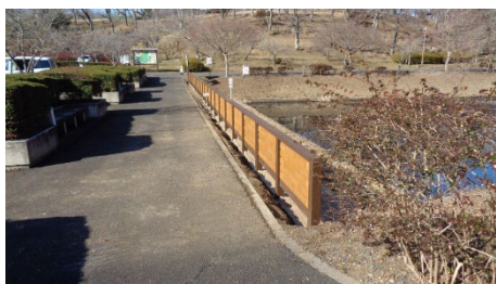
（那珂市設置状況）
