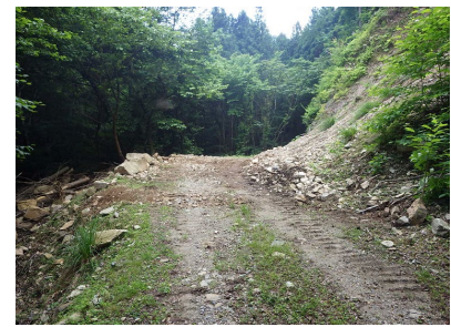
(路面補修工実施後)
