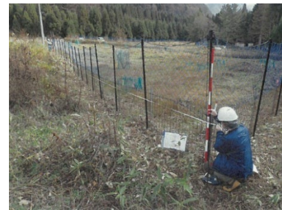
獣害防除柵設置（米子）
