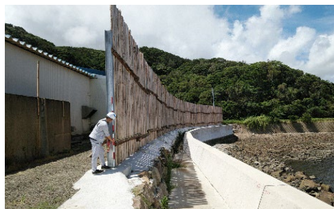
（防風柵の設置）
