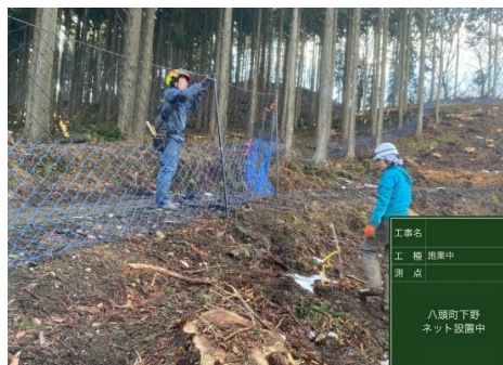
(シカ防護ネット設置)
