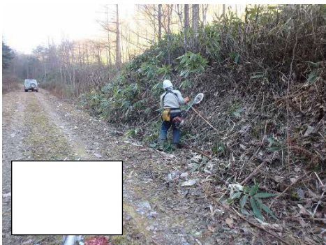
（路肩・法面伐開）
