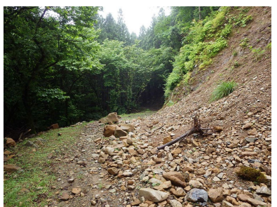
(路面補修工実施前)
