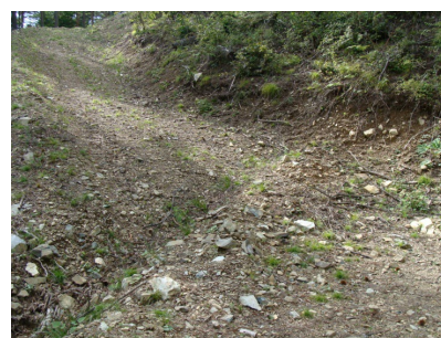
素掘りによる横断溝
