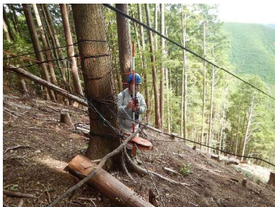
＜先柱の位置確認＞
