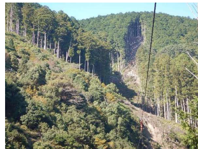
＜架線索張状況＞
