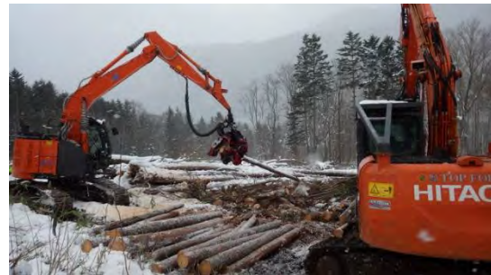
▲ICT ハーベスタ現地実証状況②
