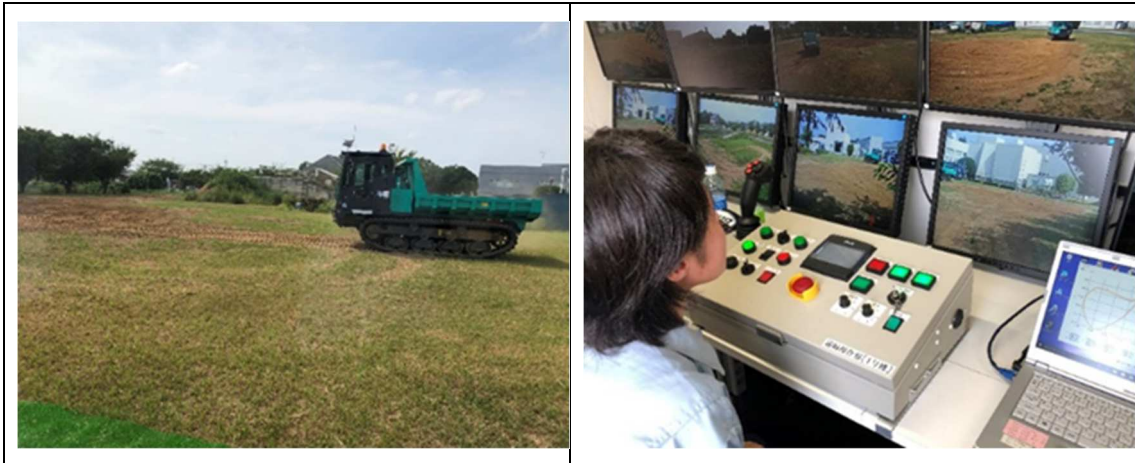
図 3.7 クローラキャリアの自動走行（左）と操作室における教示運転（右） （於：熊谷組筑波技術研究所）
