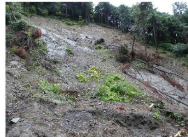
図-6-10 流れ盤構造の片理面をすべり面とした表層崩壊 (土層が厚く、樹木の根系が基岩まで到達できなかったか、もしくは根系が到達したとしても基岩に節理が少なく、根系が基岩内に伸張できなかったと考えられる。)
