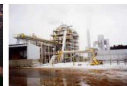
木質バイオマス利用施設
