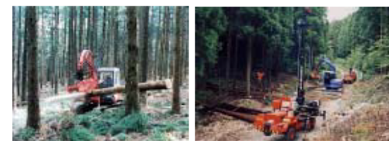
高性能な林業機械による作業が可能となる路網整備
