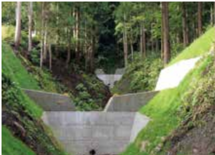
治山施設と整備された森林
