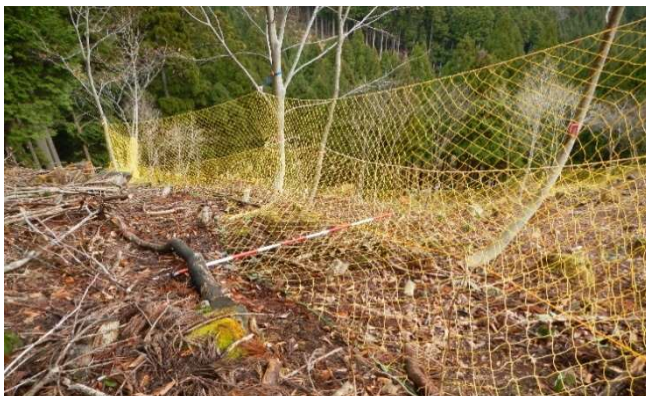
図表 スカートネットの設置状況
