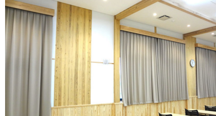
（CLT現しを採用した会議室の壁）
