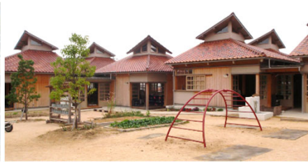
（縦ログ構法による木あrawし仕上げの内外装）
