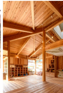
（縦ログ構法による木あrawし仕上げの内外装）
