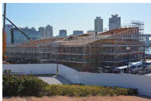
秋田スギ製品を供給した建設中の非住宅物件(東京都江東区/豊洲)
