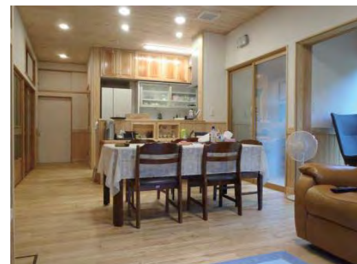
地域材を利用した新築住宅 （床材は地域のクリ材）
