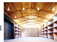
CLTを活用した設計・建築実証
