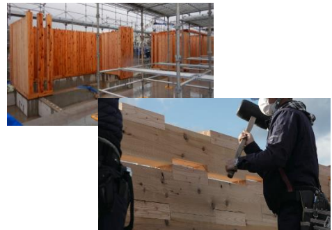
図2 縦ログ、重ね梁の施工
