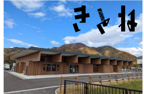
図1 縦ログと重ね梁が特徴的な外観
