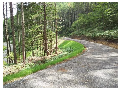
図1 開設した林業専用道
