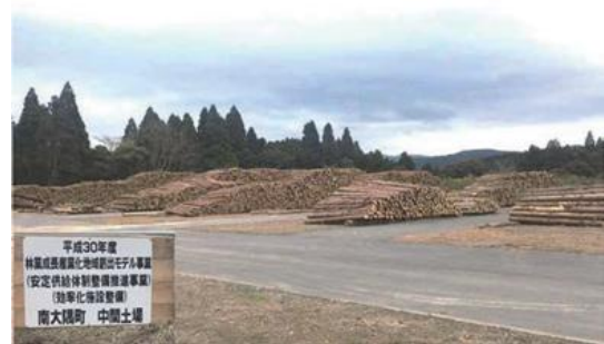
図表 1-3 整備された中間土場 （資料：鹿児島県大隅地域振興局）
