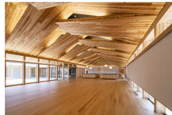
（CLTが折り重なるように連続した天井）
