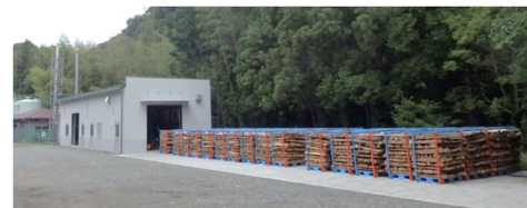
（薪ボイラー施設）
