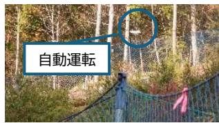
ドローンによるシカ防護柵の点検
