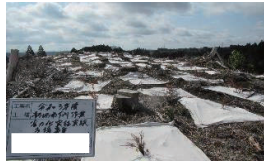
（防草シート設置状況）
