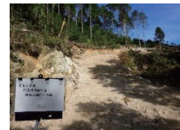
（森林作業道補修支援） 作業完了後
