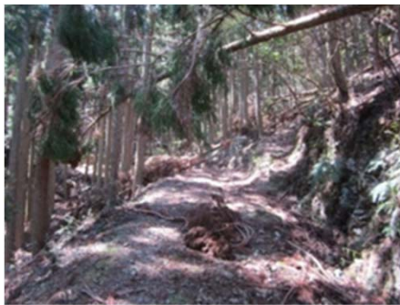
＜修繕前の作業道＞
