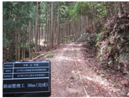
＜修繕後の作業道＞
