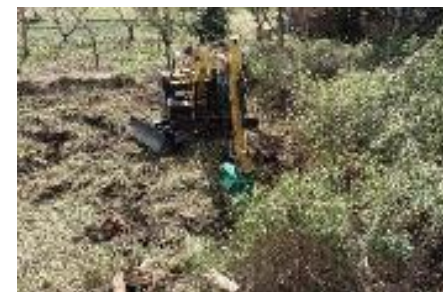
〈機械による地拵作業〉
