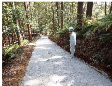
（コンクリート路面工）
