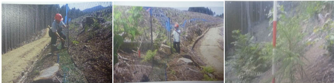
（防護柵点検・補修）
