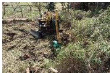
（地拵作業状況）
