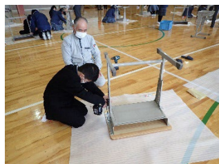
（天板設置の様子）
