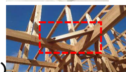
← 天瀬総合福祉センター等複合施設 (火打ち材として使用)
