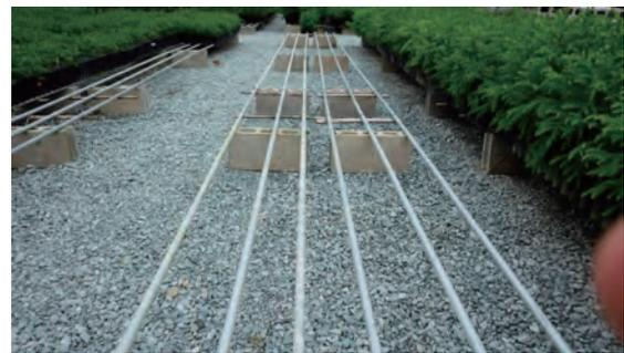
コンクリートブロックとアングル鋼やチャンネル鋼等の鋼材を組み合わせた育苗ベンチ
