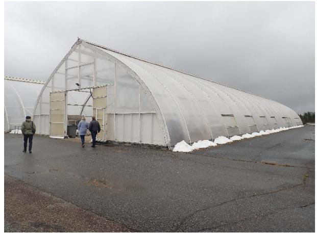
温室。フィルムが2重構造になっており、冷気の遮断ができる。暑いときは側面の窓を開く。
