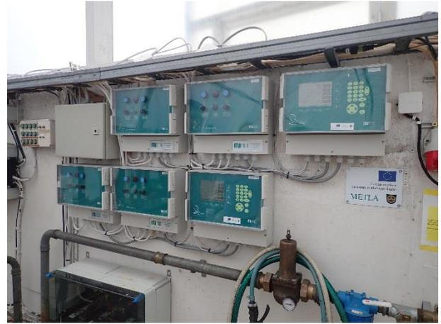
温度管理装置。温水パイプをハウス内に巡らせて温度調節をする。
