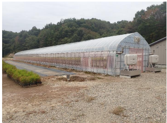
写真 3-21 石油ボイラー付きビニールハウス
