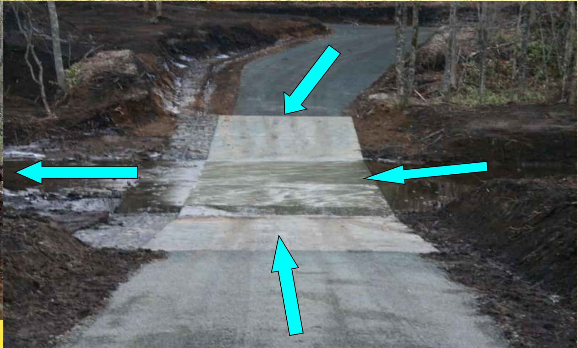
地形に沿った曲線設置と、地形に応じた縦断の低勾配化により、切土・盛土高の最小化を行った施工状況（工事土工量の低減）
