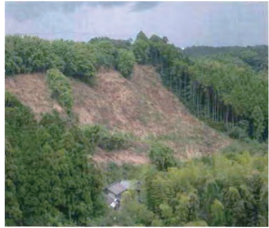
写真-8 事業地全景 (平成22年7月下刈り後)
