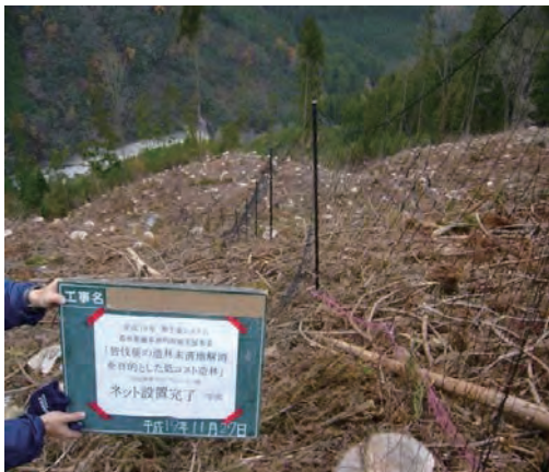
写真-3 ネットの設置
