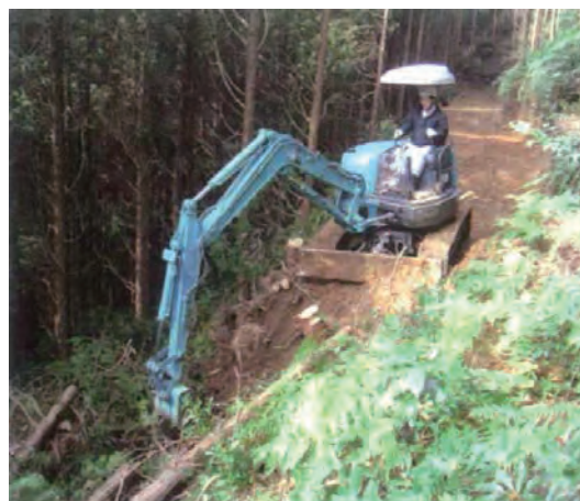
写真-2 表土ブロック積み工法
