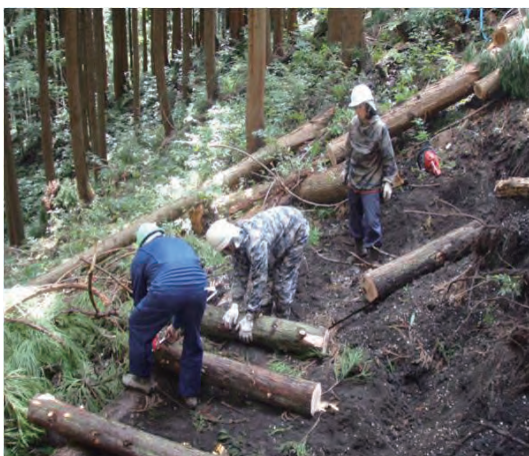
写真-3 作業路開設風景
