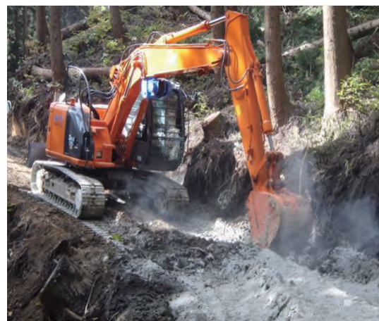
写真-4 土壌凝固剤の使用
