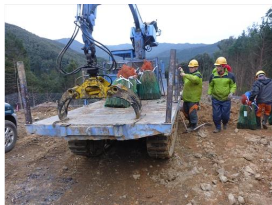
④フォワードによるコンテナ苗の運搬
