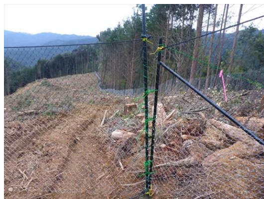
①防鹿ネットを植付け前に設置
