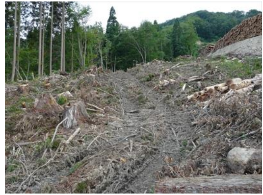
②造材発生時の枝条は、森林作業道に敷設
