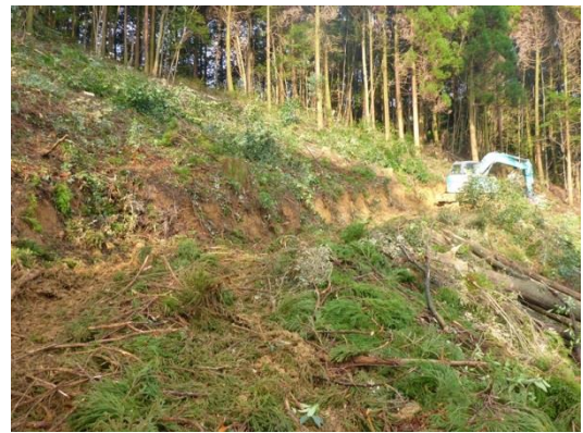
②スリップ防止の為に、森林作業道上にスギ枝条を敷設
