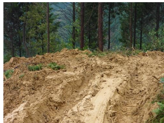
②スリップ防止の為に、スギ枝条を敷設
