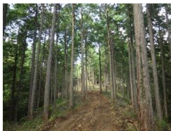
写真 4.2-2 作業道開設状況
