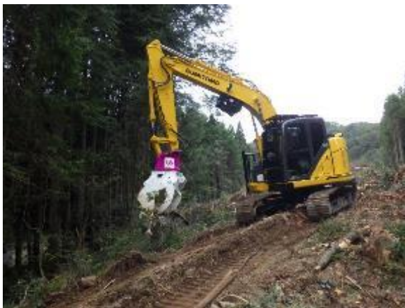
フェラー付きグラップルバケットローダーによる地拵え
