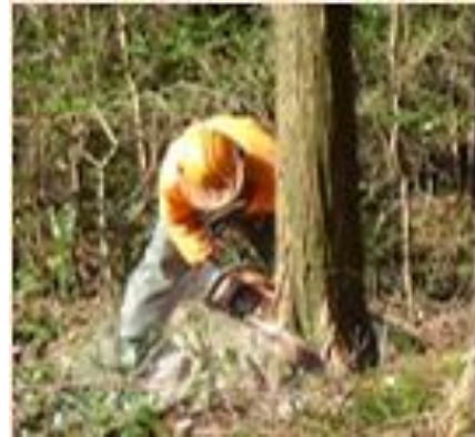
チェーンソーによる伐倒
