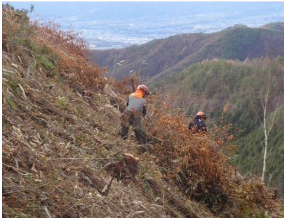
人力地拵えの状況
