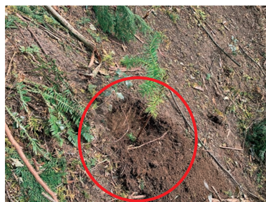
写真6 シェルター設置用に接地面を整えた
