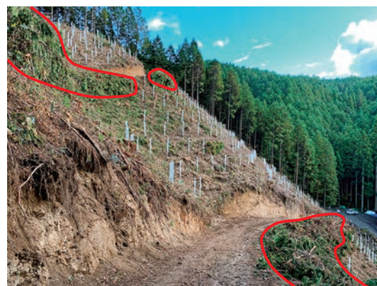
写真5 作業道谷側に集積された枝条（赤枠部分）
