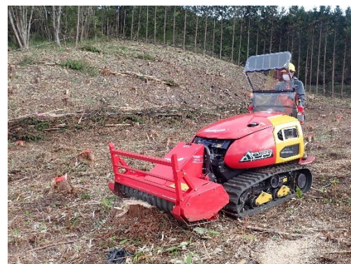
写真 10 刈刃機械一体型機械で切株破碎処理する様子
