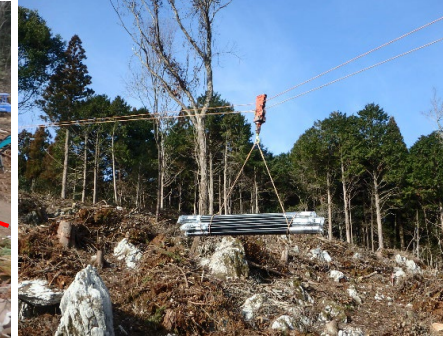
スイングヤーダによる資材運搬
